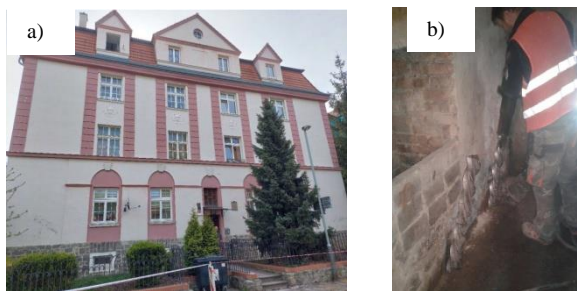
Fot. 3. Kamienica w Uście nad Łabą w Czechach: a) widok ogólny, b) montaż mikropali od strony pomieszczeń Photo 3. Tenement house in Usti on the Elbe River, Czech Republic: a) general view, b) installation of micropiles from the room side
